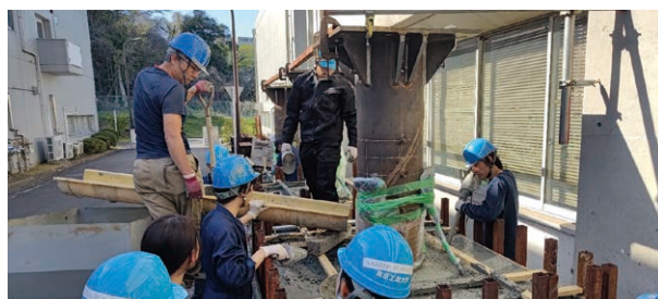
鋼管コンクリート杭試験体のコンクリート打設 Casting of concrete for concrete-filled steel tube pile specimens
