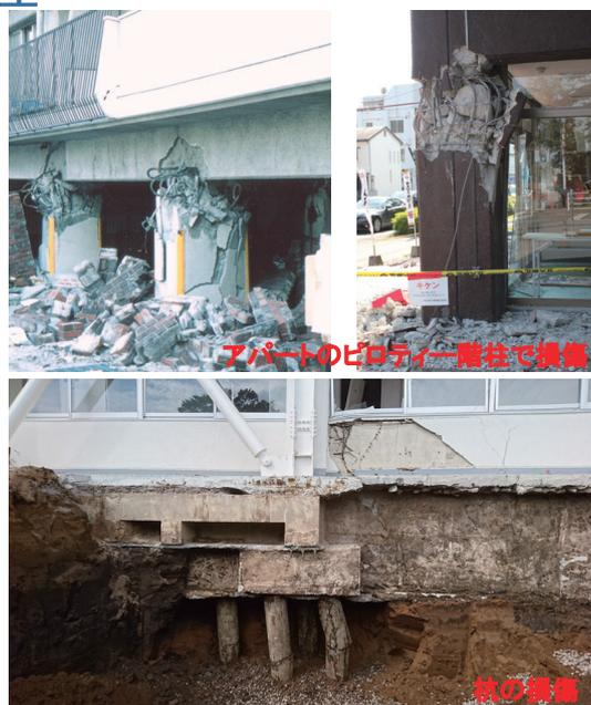
地震による柱や杭の被害状況
