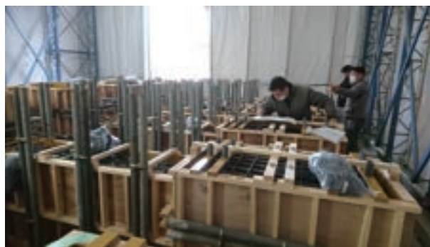
RC試験体のコンクリート打設を前に、配筋検査を行っている様子
